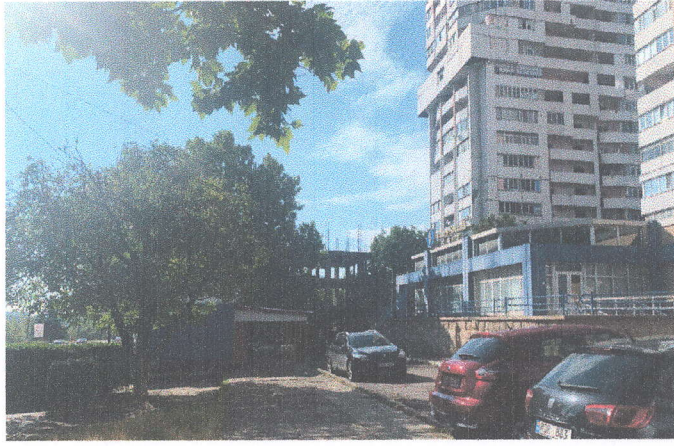
5. CONSTRUCTIE NEFINISATA / BANCA SOCIALA
