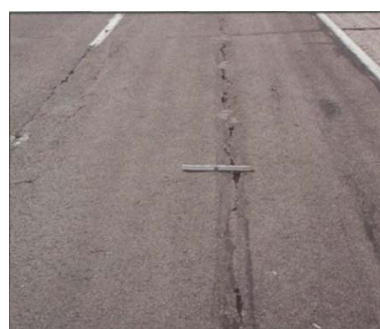
Figura 30 - Fisuri și crăpături longitudinale. Fotografii
