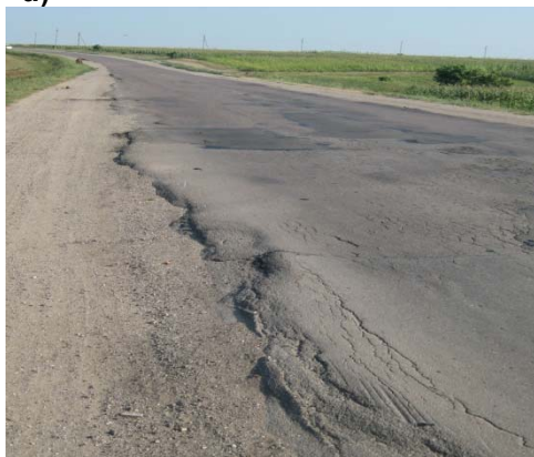
Рисунок 10 – Сдвиги (наплывы)
