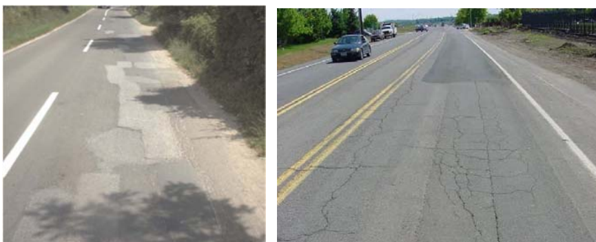
Рисунок 24 - Заплатки среднего уровня опасности
