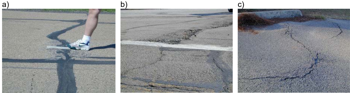
а) - низкий уровень опасности (S); б) - средний уровень опасности (М); с) - высокий уровень опасности (R)
