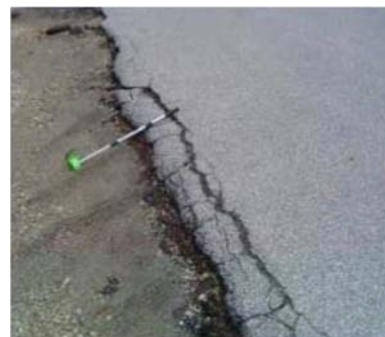
а) - низкий уровень опасности (S),); b) - средний уровень опасности (M) с) - высокий уровень опасности (R),
