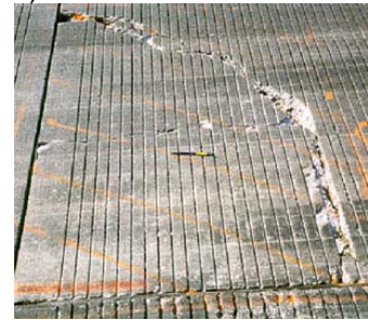
Figura 63 – Niveluri de severitate ale fisurilor și crăpăturilor diagonale
