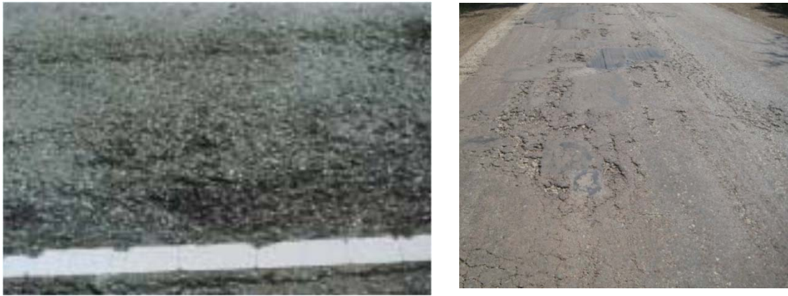
Рисунок 6 – Выкрашивание поверхности
