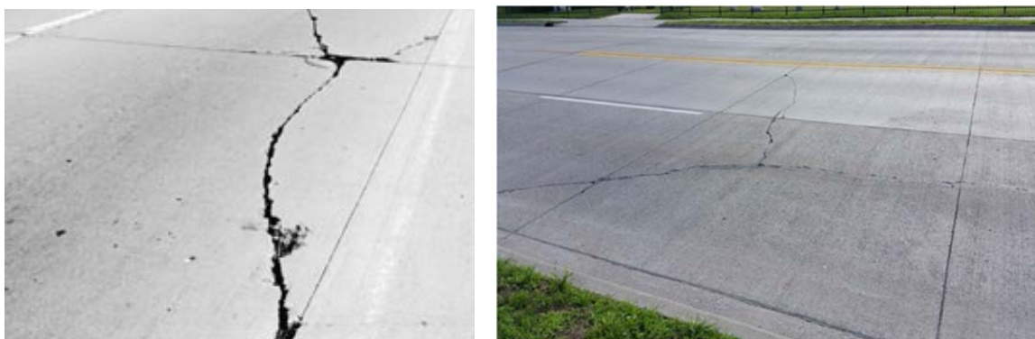
Рисунок 60 – Диагональные трещины
