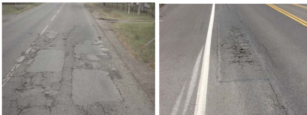
Рисунок 25 - Заплатки высокого уровня опасности
