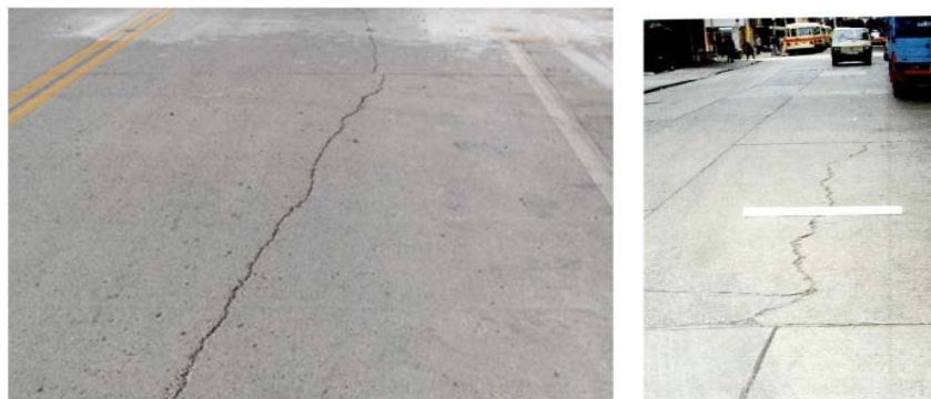
Рисунок 58 – Продольные трещины
