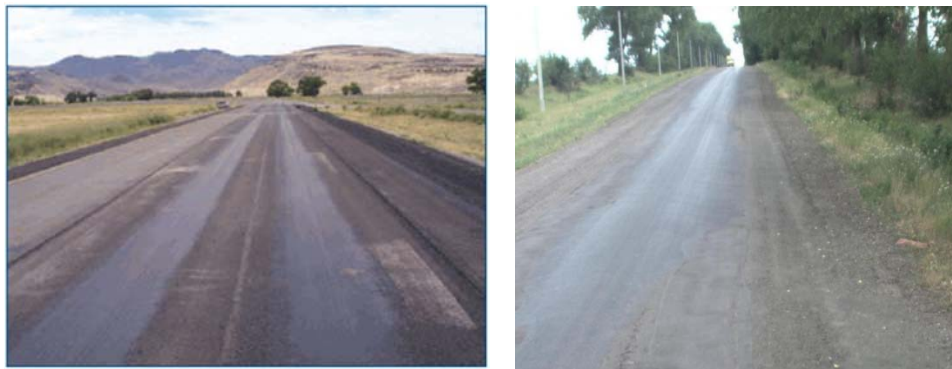
Рисунок 2 - Выпотевание вяжущего
