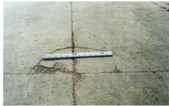
Figura 62 – Fisuri și crăpături de colț
