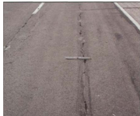
Рисунок 30 – Продольные трещины. Фотографии
