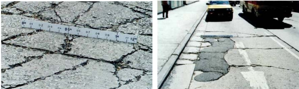
Рисунок 68 – Сетка трещин
