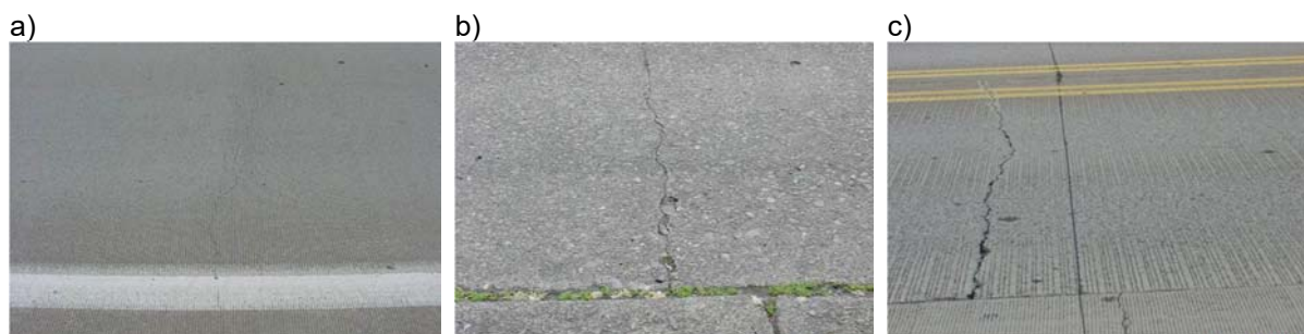
a) – низкий уровень опасности (S); b) – средний уровень опасности (M); c) – высокий уровень опасности (R)
