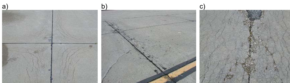
а) – низкий уровень опасности (S); б) – средний уровень опасности (M); в) – высокий уровень опасности (R)
