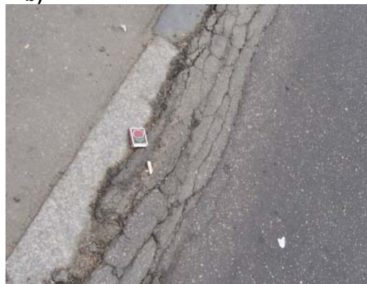
Рисунок 10 – Сдвиги (наплывы)
