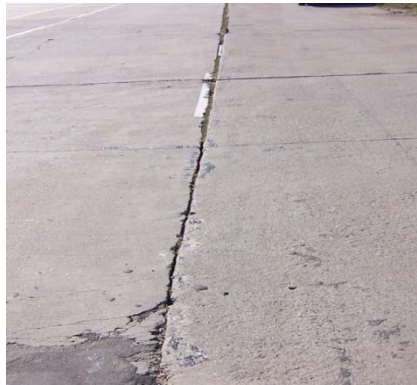
Figura 50 - Deschiderea rosturilor longitudinale
