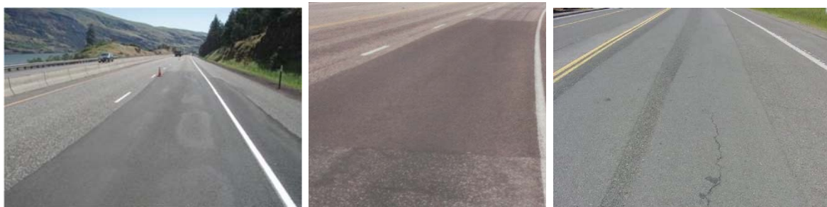
Рисунок 23 – Заплатки низкого уровня опасности
