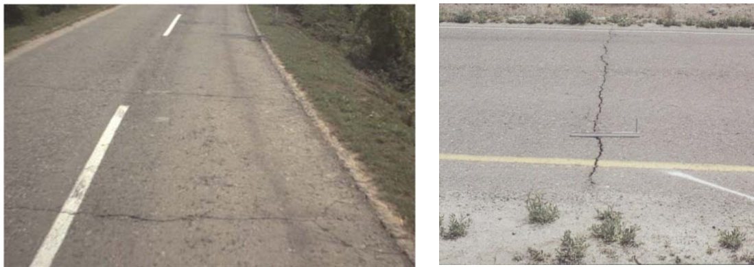
Рисунок 27 – Поперечные трещины
