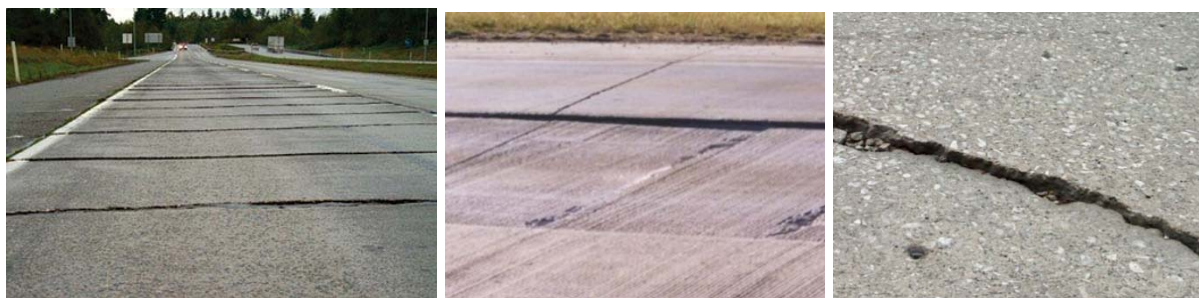
Рисунок 66 – Просадка плит
