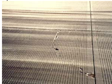
Figura 63 – Niveluri de severitate ale fisurilor și crăpăturilor diagonale
