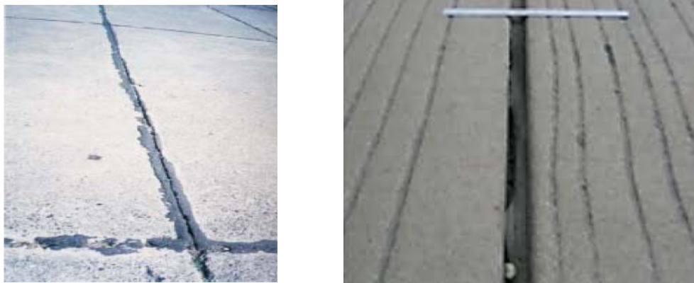
Рисунок 48 - Разгерметизация швов
