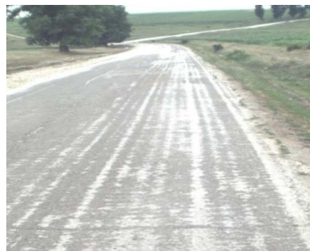
Рисунок 4 - Облысение в виде продольных полос
