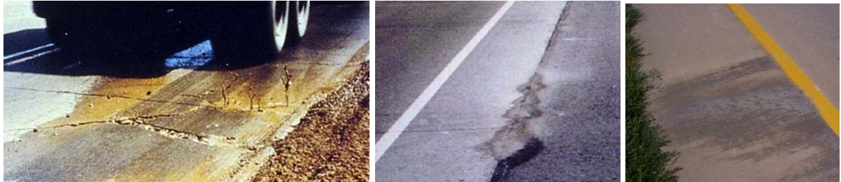
Рисунок 65 – Выдавливание
