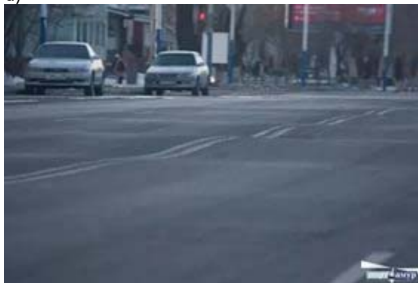
Figura 9 - Văluriri pe suprafața îmbrăcămintei
