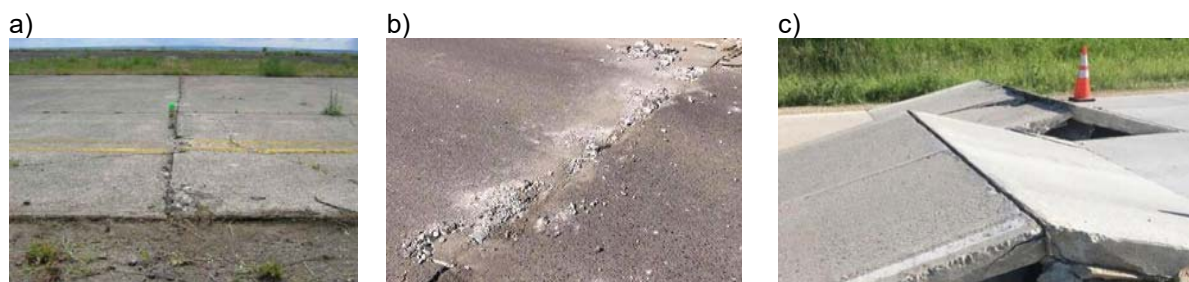
а) – низкий уровень опасности (S); b) – средний уровень опасности (M); c) – высокий уровень опасности (R)
