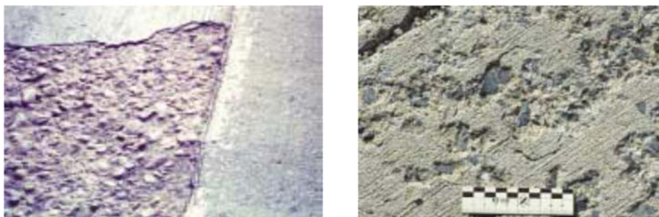
Рисунок 45 - Отслаивание
