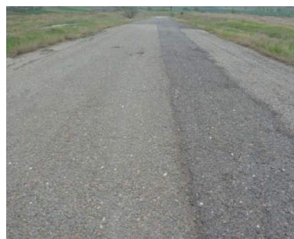
Рисунок 5 – Пористая поверхность
