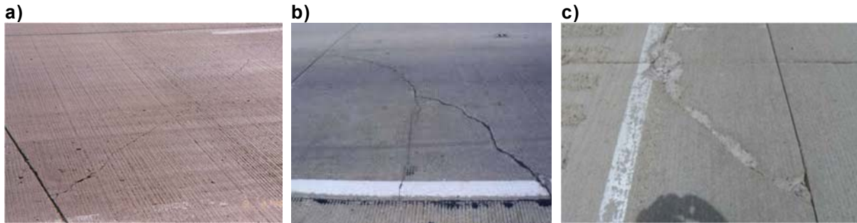
а) – низкий уровень опасности (S); б) – средний уровень опасности (M); с) – высокий уровень опасности (R)
