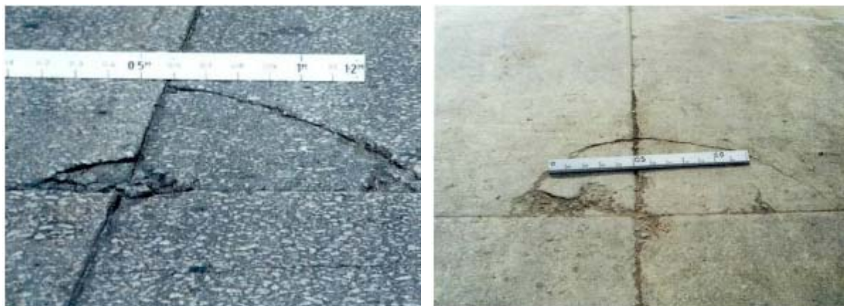
Рисунок 62 – Угловые трещины
