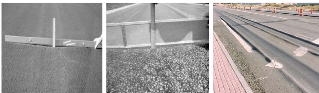
а) - низкий уровень опасности (S),); b) - средний уровень опасности (M) с) - высокий уровень опасности (R),
