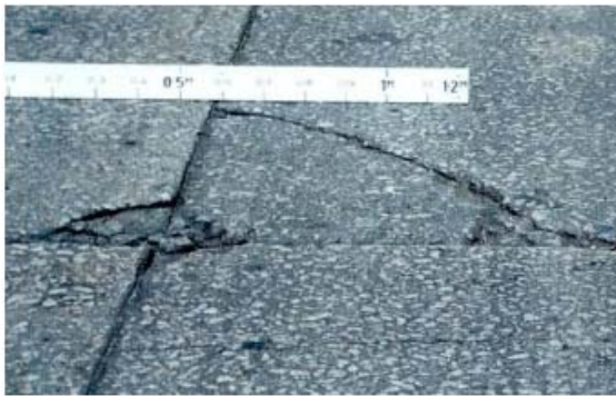
Figura 62 – Fisuri și crăpături de colț
