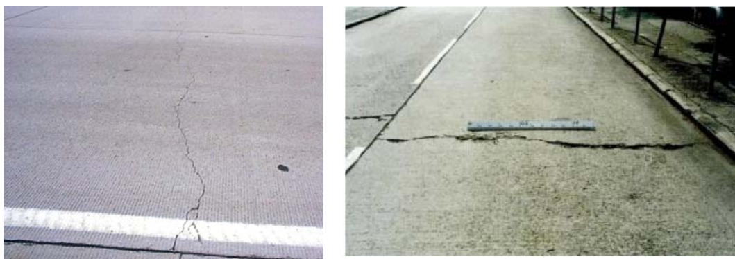
Рисунок 56 - Поперечные трещины
