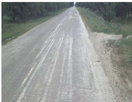
Рисунок 4 - Облысение в виде продольных полос
