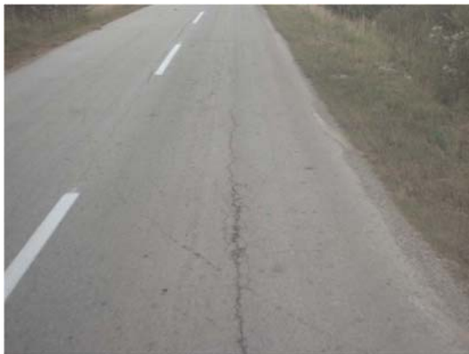
Рисунок 30 – Продольные трещины. Фотографии
