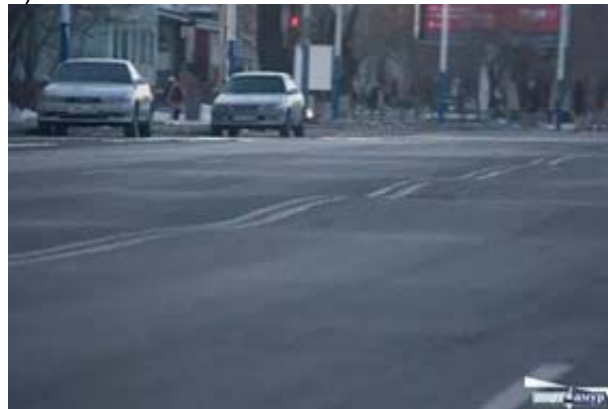
Рисунок 9 – Волнистость на поверхности покрытий
